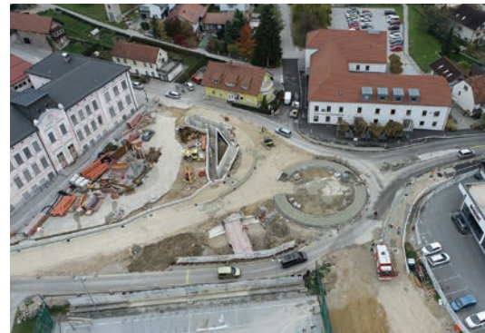
Gradnja krožišča pri OŠ Franja Malgaja
