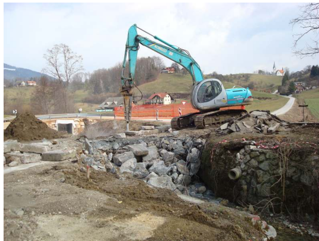
Rušenje Hajderjevega mostu
