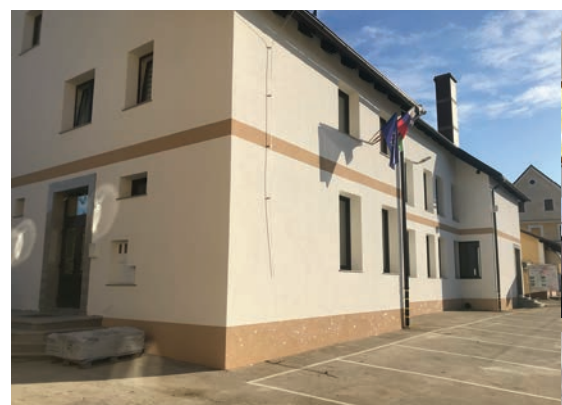
Kulturni dom Dobje po energetske sanaciji
