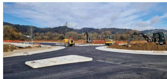
Zaključna dela v industrijski coni Šentjur
